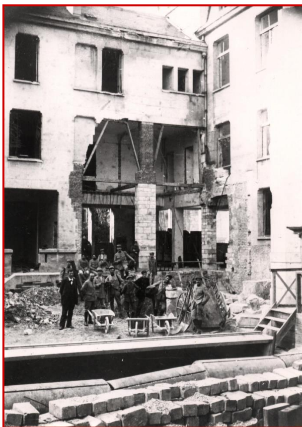
Hôtel des Postes de Châlons (Marne). Les réparations sont en cours, mars 1918. Photo Pierre Fontugne. Coll. Lorhistel.
