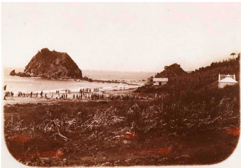
Installation du câble Dakar – Fernando de Noronha – Recife par la SACC en 1892.
